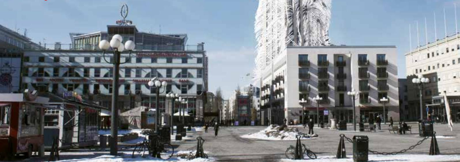
El proyecto «Strawscraper» consiste, básicamente, en incorporar a uno de los edificios residenciales más altos de Estocolmo una extensión estructural y una nueva cubierta compuesta por una gran cantidad de filamentos piezoeléctricos, que generarán corriente eléctrica cuando los agita el viento.
